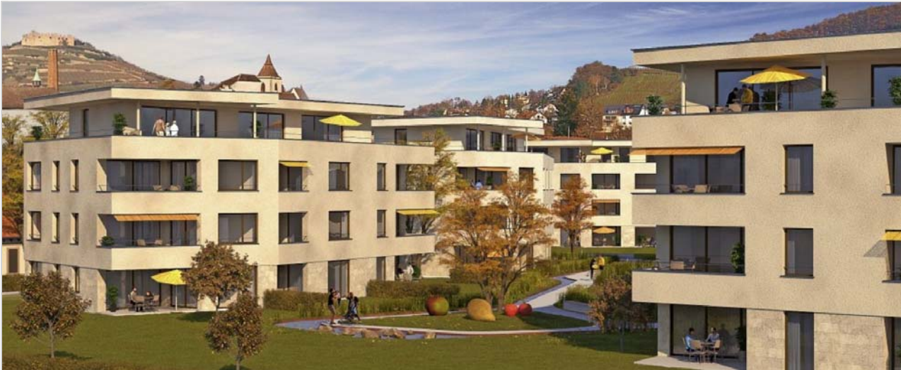
So soll die Wohnbebauung auf dem Schladerer-Areal in Staufen einmal aussehen. Foto: Visualisierung: Firma Gisinger
