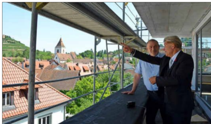
Bauleiter Andreas Sans (links) und Geschäftsführer Christian Engelhard informieren sich über den Baufortschritt.
