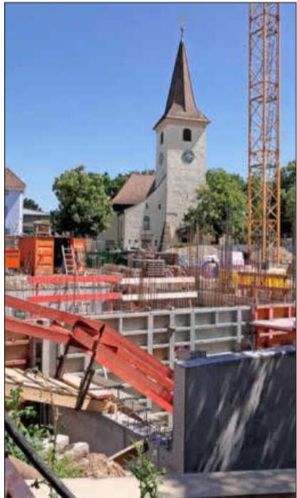
In eine große Baugrube blickt man im Zentrum von Bad Krozingen.
