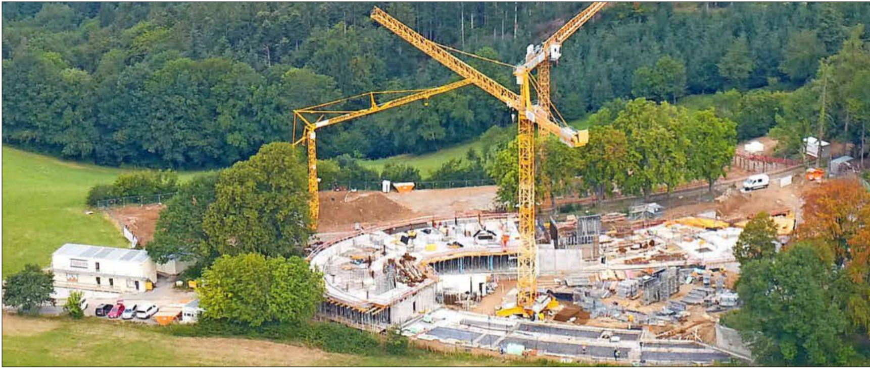
Derzeit die höchst gelegene Großbaustelle im Breisgau: Das Luxushotel Luisenhöhe entsteht in Horben.
