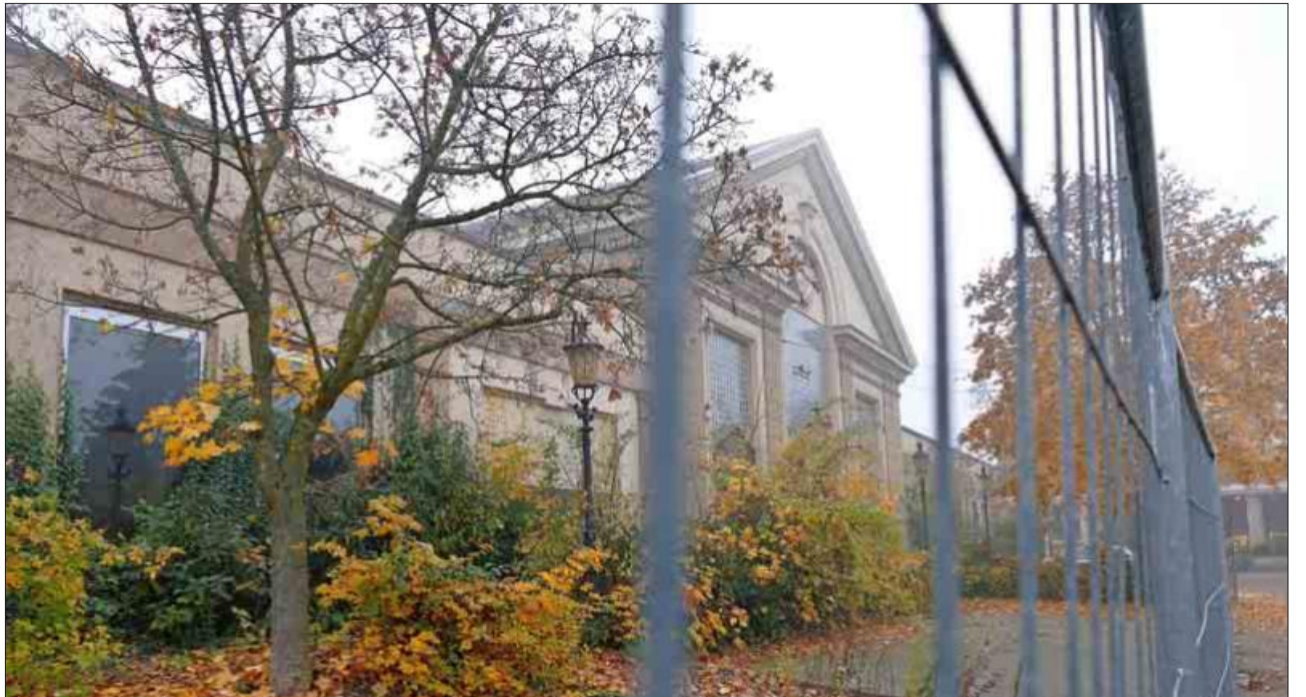
Die ehemalige Cusenier-Likörfabrik an der Müllheimer Straße soll zur Wohnnutzung umgebaut werden FOTO: EHM
