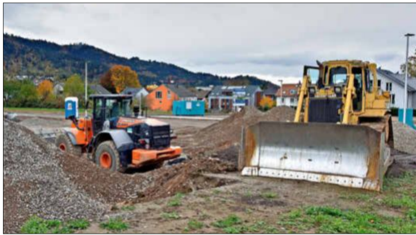
Erschließungsarbeiten am Ortsrand von Ebnet
