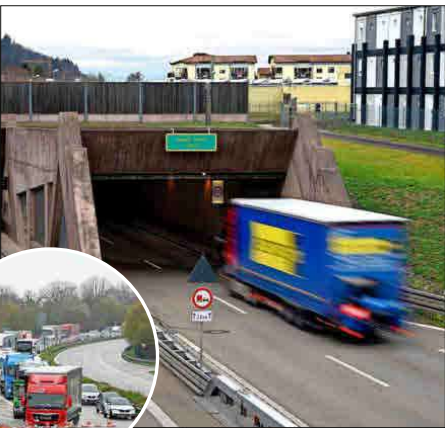
Wenn Stau droht, schaltet die Ampel vor dem Kappler Tunnel auf Rot und die Schranke schließt sich (so wie 2019 bei einem LKW-Unfall – rundes Foto). FOTOS: THOMAS KUNZ / INGO SCHNEIDER
